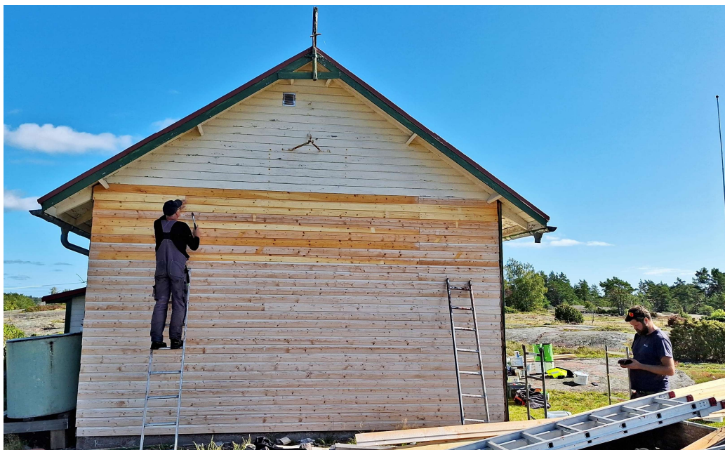
Bild: Fastighetsverkets Mika Marttila och Stefan Westman renoverar kulturhistorisk byggnad på Rödhamn. Foto: Jani Johnsson, Fastighetsverket
